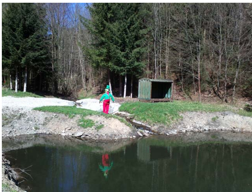
Malá vodní nádrž TP Kamenná chaloupka po revitalizaci
