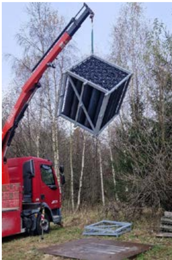
Pádové zkoušky transportního systému
